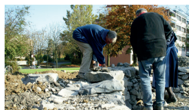
Erstellung von verschiedenen Strukturelementen, wie Trockenmauern
